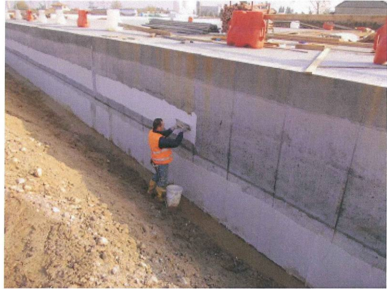
Applicazione Elasplast in verticale sulla spalla laterale prima del rinterro
