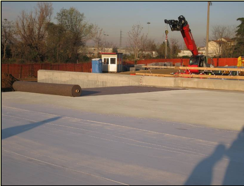
Applicazione Elasplast in verticale sulla spalla laterale prima del rinterro
